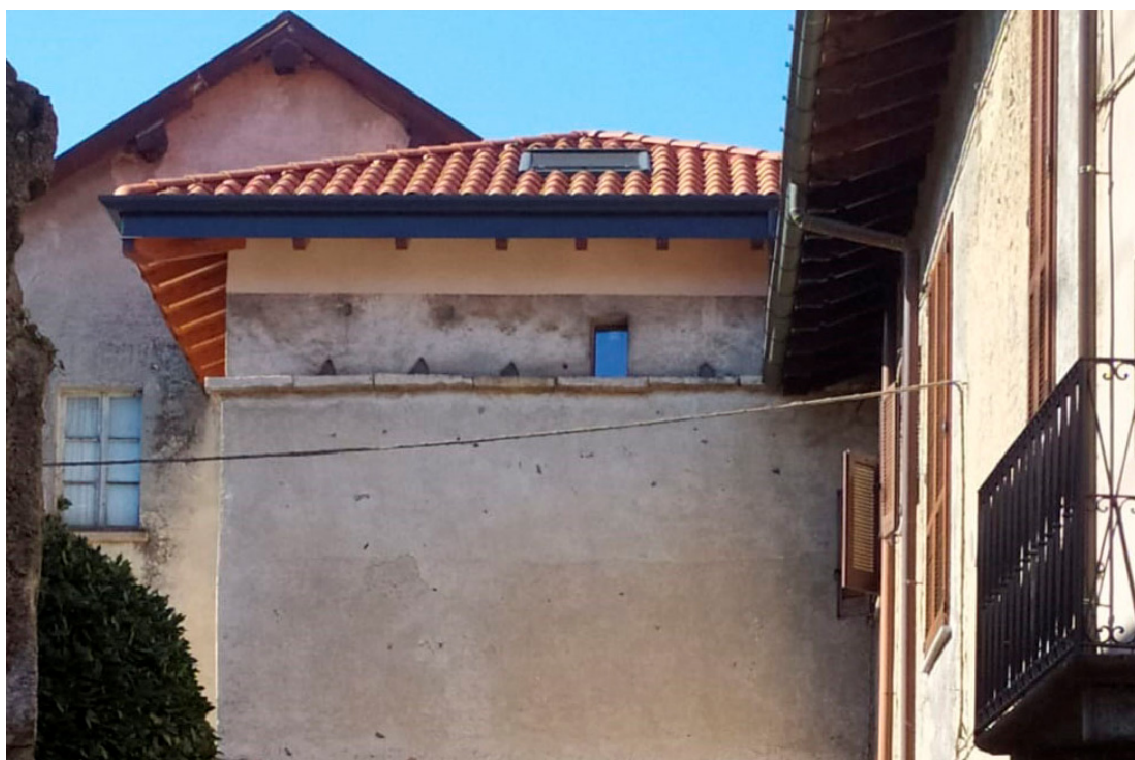
Angera (VA) – Esempio di torre mista resa inaccessibile per via della ristrutturazione che ha previsto la chiusura degli ingressi con cemento. © Daniela Casola
