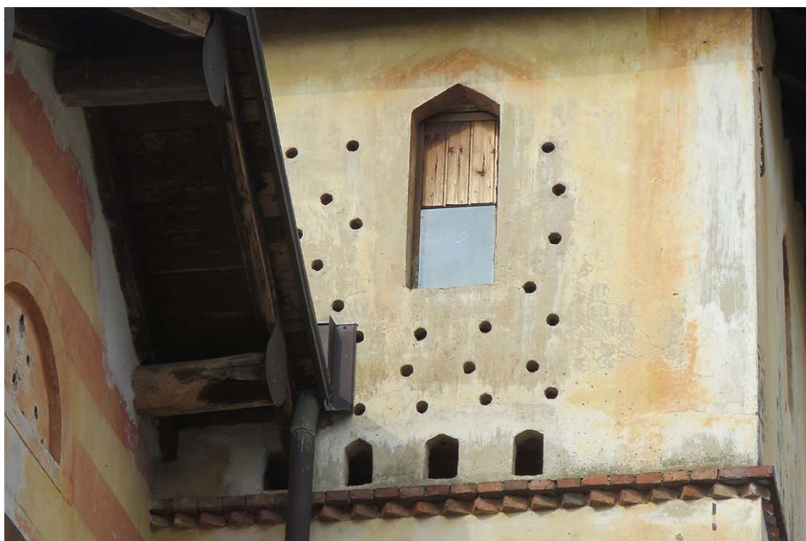
Marchirolo (VA) – Edificio dell'Ottocento che presenta una torre mista e due pareti per passeri. La struttura è stata un allevamento di piccioni viaggiatori fino al Novecento. © Lorenzo Colombo
