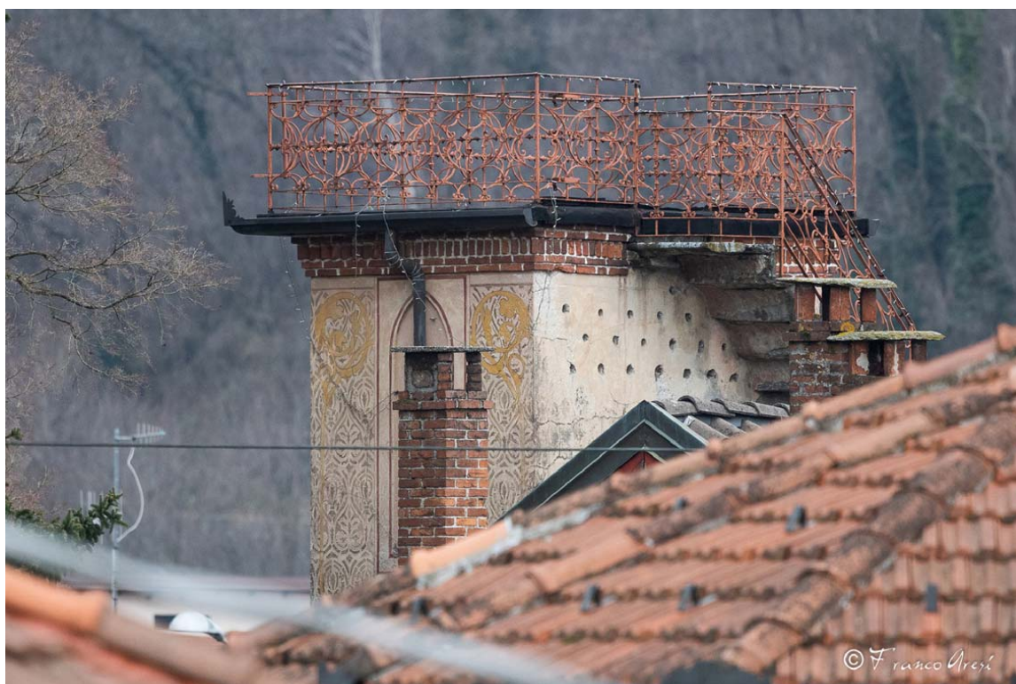
Cittiglio (VA) – Esempio di passeraia su torre di un edificio di fine Ottocento con 19 accessi esposti a ovest. © Franco Aresi
