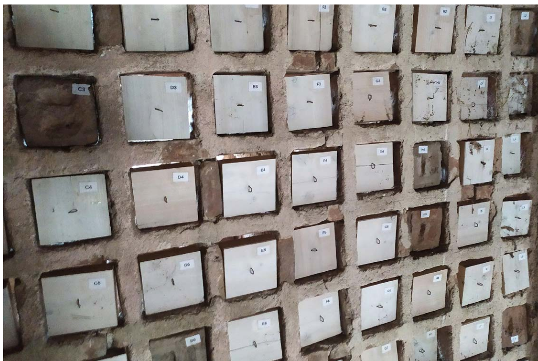
Azzate (VA) – Passeraia ripristinata con il recupero delle mattonelle originali per la chiusura delle celle o con la realizzazione di quadrelli di legno sostitutivi. © Milo Manica
