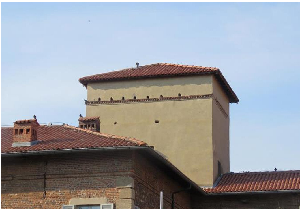
Figura 6 - Casa torre con colombaia, facilmente riconoscibile dalla dimensione e dalla forma dei fori di accesso, come pure dal tipico cornicione utilizzato quale posatoio – Fagnano Olona (VA), Castello Visconteo sec. XIII – XIV attualmente sede del Municipio. © Lorenzo Colombo
