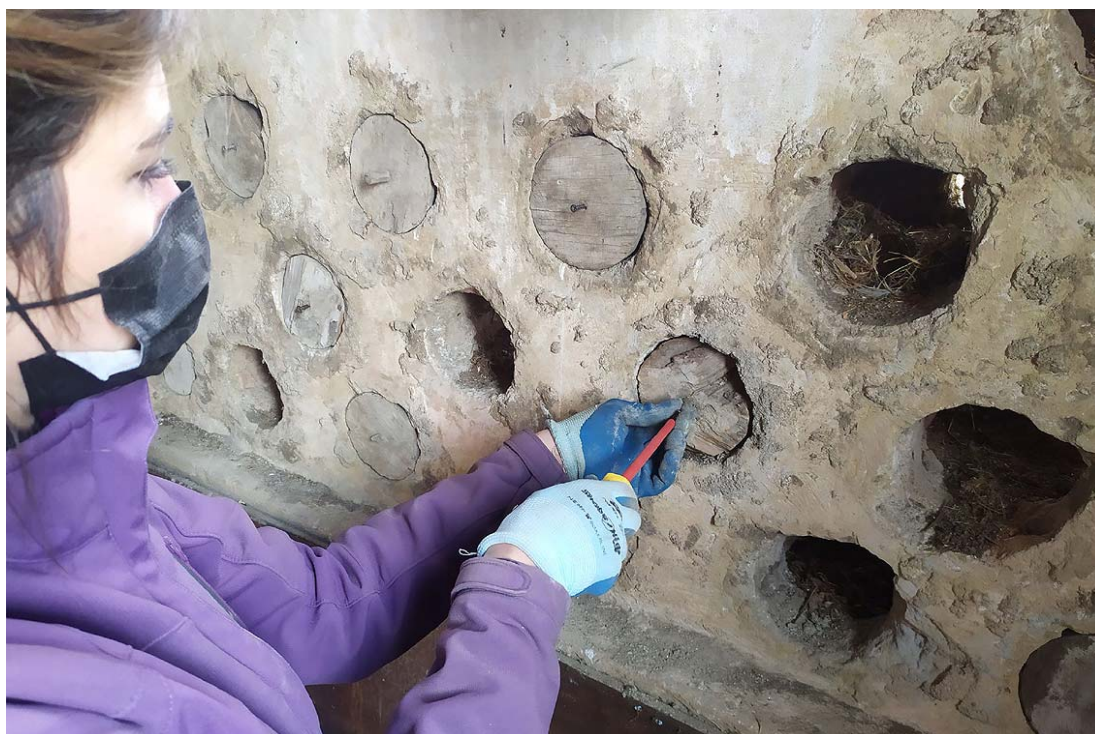
Marchirolo (VA) – Lavori di ripristino eseguiti nel 2022: si notino gli accessi alle celle dati da tappi di legno rotondi. Alcuni sono stati realizzati ex novo dal gruppo di ricerca. © Milo Manica
