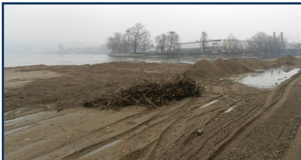
Figura 7: i lavori effettuati nel gennaio 2012.
